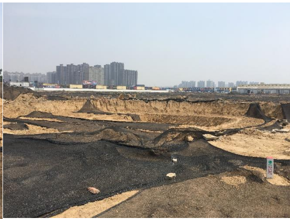
污染土清挖后现场基坑
