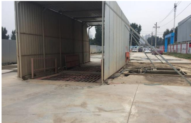
施工现场洗车池
