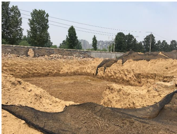
污染土清挖后现场基坑
