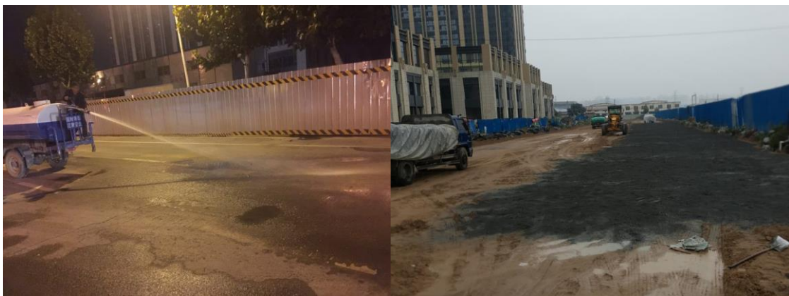
路基填埋施工现场
