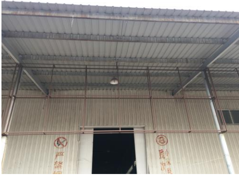
拆除修复车间门头钢结构广告牌
