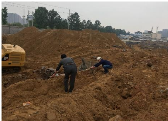
污染土清挖后现场基坑状况
