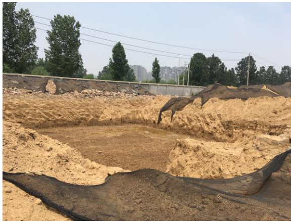
污染土清挖后现场基坑状况
