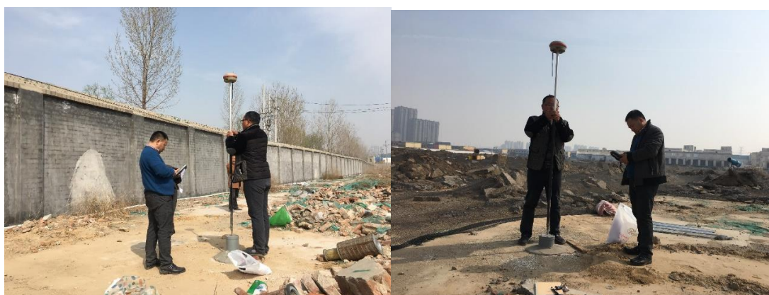
现场测量放线
