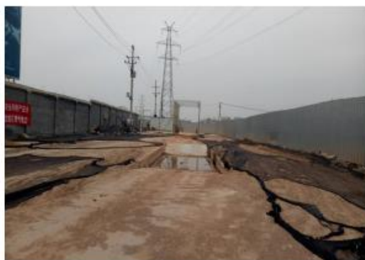
所在商城苑开发地块车辆冲洗设施
