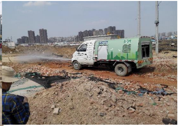
施工现场洒水车
