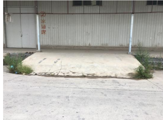
进修复车间道路进行改造
