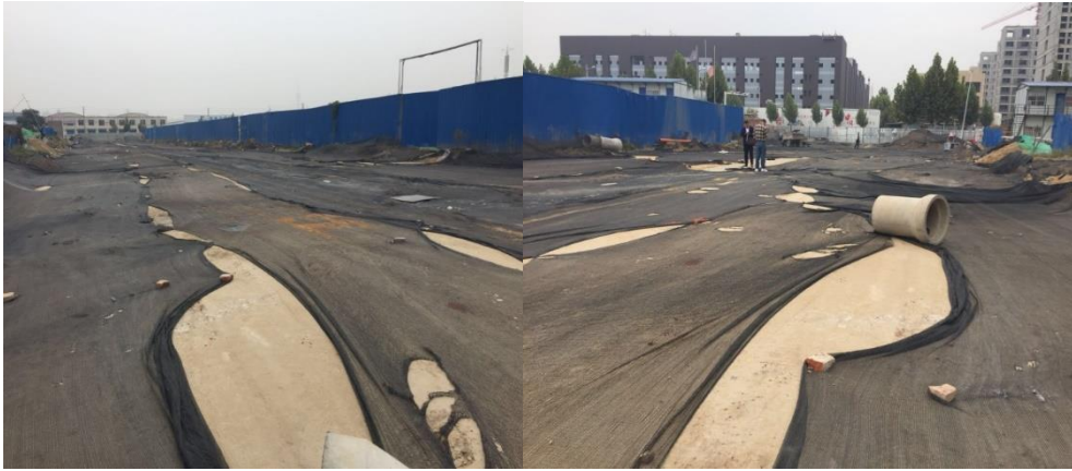
分层碾压后养护现场
