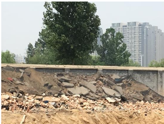
硬化地面破碎清除
